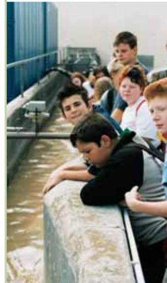
In der Kläranlage wird das Wasser in mehreren aufeinander folgenden Becken von Schmutzteilen befreit.
